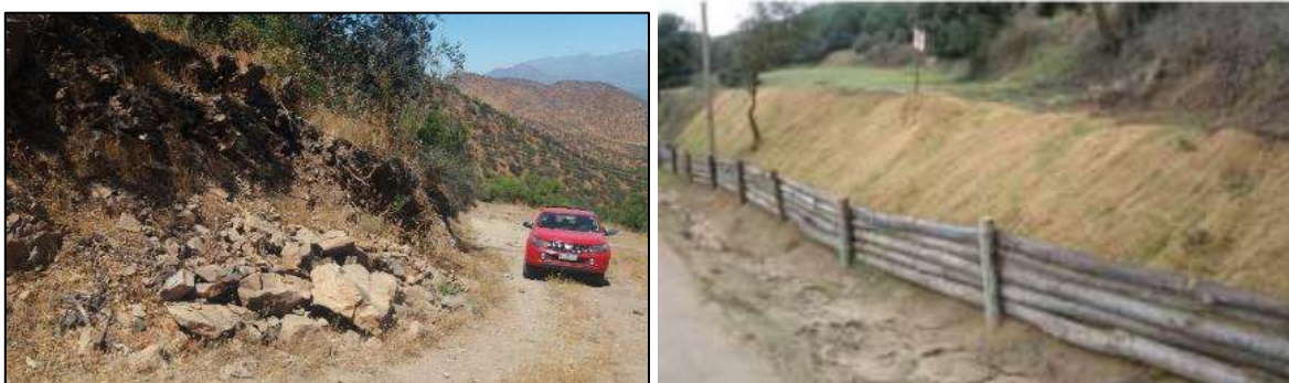
Figura 6. Camino con derrumbe de material y ejemplo de empalizada.
