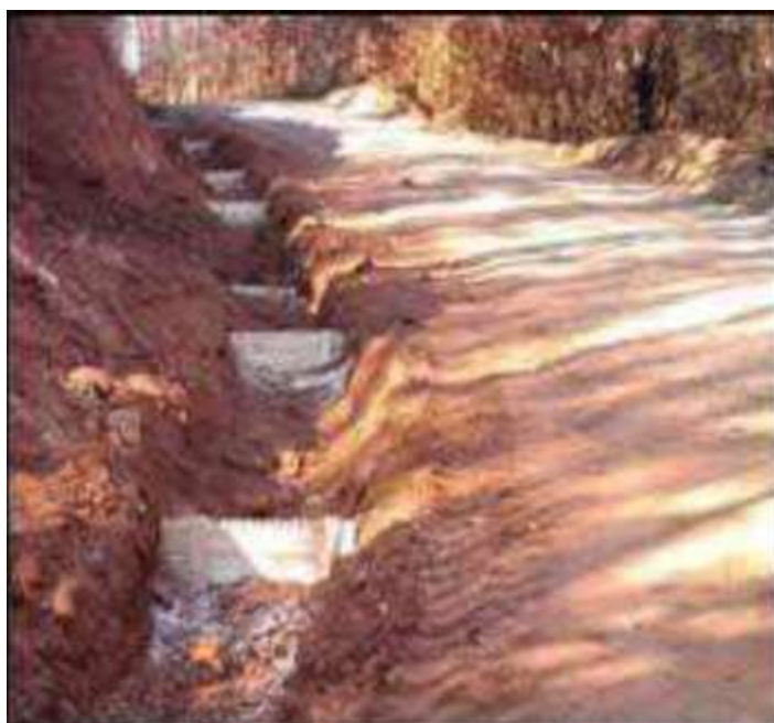
Figura 4. Ejemplo de disipadores de energía instalados en cunetas.
